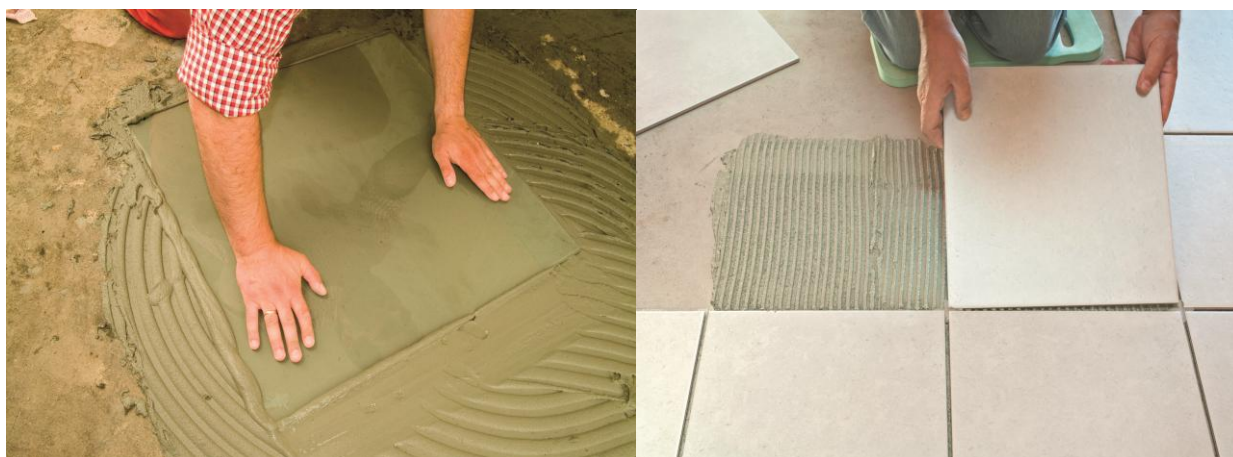
Рисунок 2 – Укладка плитки на клеевой состав
