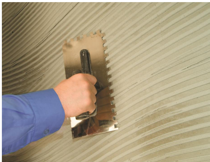
Рисунок 1 – Нанесение состава на поверхность стены
