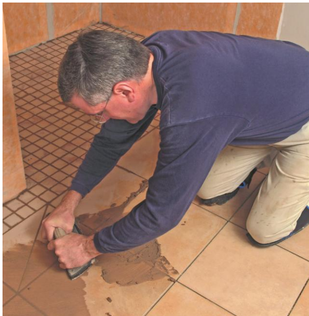
Рисунок 3 – Заполнение швов
