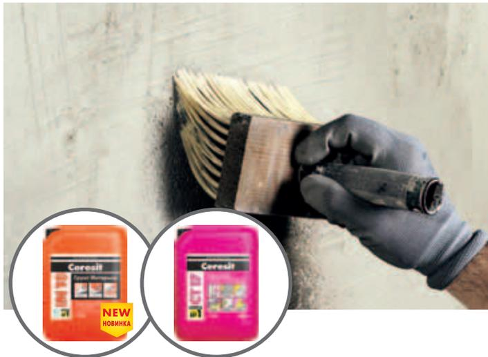
**Кладка из ячеистобетонных блоков и старые зачищенные основания** являются сильно впитывающими материалами, поэтому перед оштукатуриванием такие основания нужно как минимум дважды обработать грунтовкой глубокого проникновения **Ceresit CT 17** или **IN 10**. При первом нанесении грунтовку нужно разбавить водой в соотношении 1:1, при следующих нанесениях грунтовку не разбавляют.
