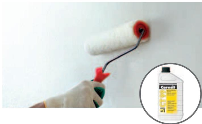
**Участки, пораженные грибком или плесенью**, необходимо очистить при помощи стальной щетки (не увлажняя поверхность), обеспылить и обработать противогрибковым концентратом **Ceresit CT 99** (стр. 18).
