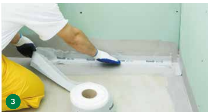
3 Герметизация угловых или соединительных швов водонепроницаемой лентой Ceresit CL 152 путем вклеивания ее в первый слой гидроизоляции с помощью мастики Ceresit CL 51 .
