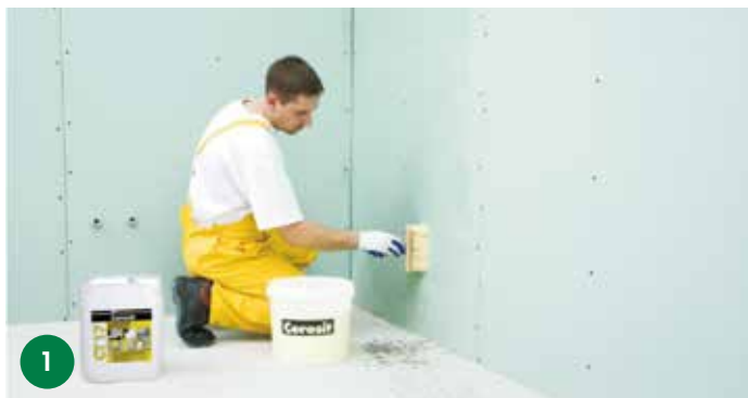
1 Обработка основания грунтовкой глубокого проникновения Ceresit CT 17 .
