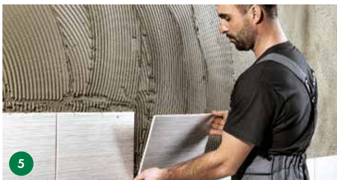
5 Крепление облицовочных плиток с помощью эластичного клея Ceresit CM 16 Flex (не ранее чем через 16 часов после нанесения последнего слоя гидроизоляции).
