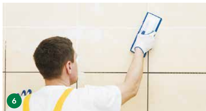
6 Заполнение швов облицовки эластичной водоотталкивающей затиркой Ceresit CE 40 Aquastatic (не ранее чем через 24 часа после крепления плитки).
