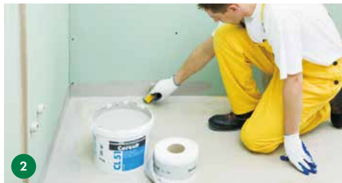
2 Нанесение первого слоя гидроизоляционной мастики Ceresit CL 51 при помощи кисти, мехового валика или шпателя.
