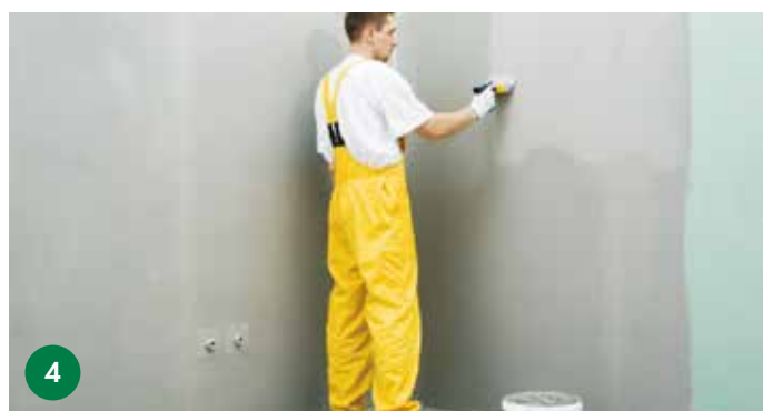
4 Нанесение второго слоя гидроизоляционной мастики Ceresit CL 51 (примерно через 2 часа после нанесения первого слоя).
