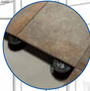
Укладка на опоры Posa sopraelevata Raised installation
